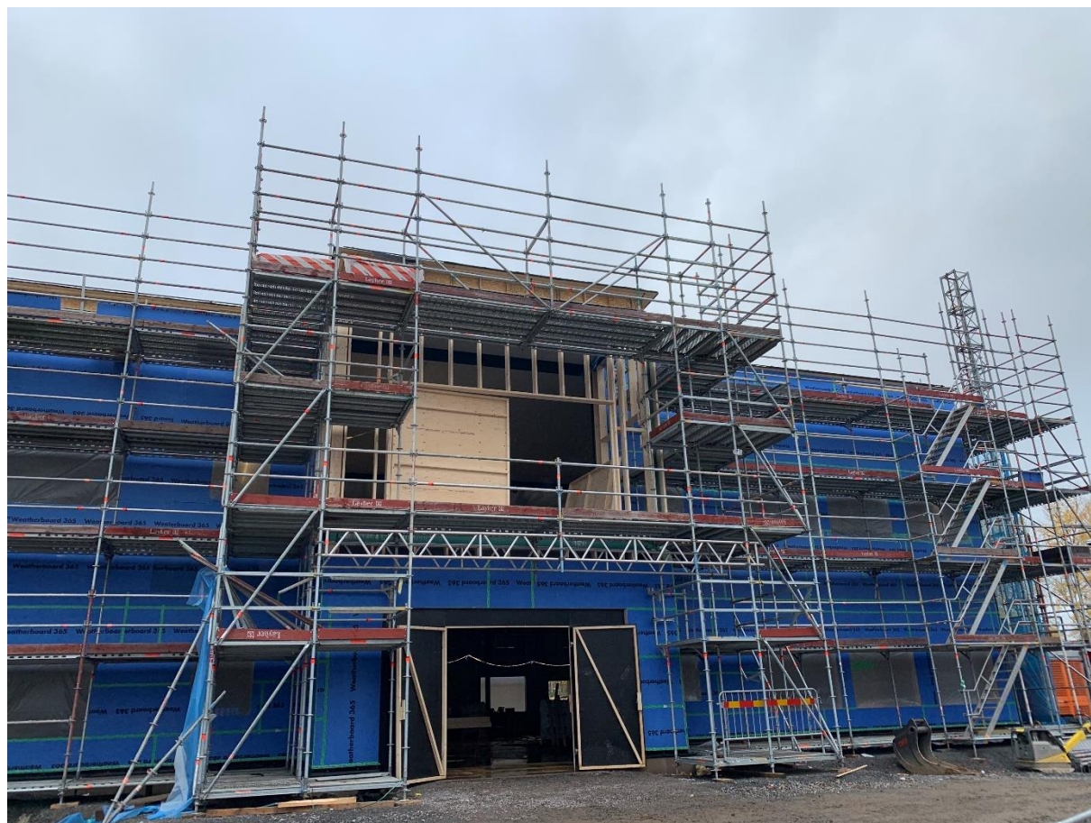
Etapp 2 av byggnationen på Närlundaskolan påbörjades under året.
