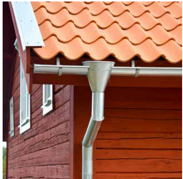
Enkupigt lertegel och fina detaljer i förzinkad plåt.
